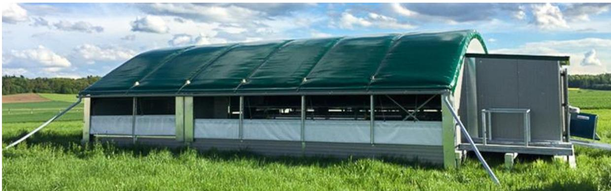
**Abbildung 1: Teilmobiler Runbogenstall auf Kufen der Firma Würdekemper,**
