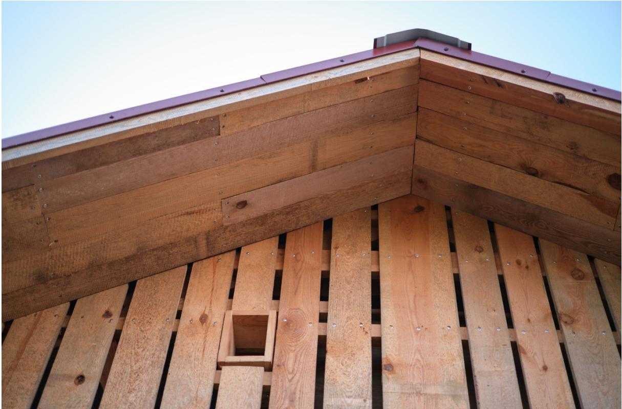
Abb. 17: Eingangsöffnung zum Schleiereulenkasten. Dieser ist hier direkt in den Dachstuhl integriert.
